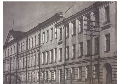
Начало библиотеки, 1930 г. Слияние фондов трех отраслевых библиотек Механического, Энергетического и Химического институтов. Ул. Молодогвардейская, 131, 1-й этаж – библиотека
